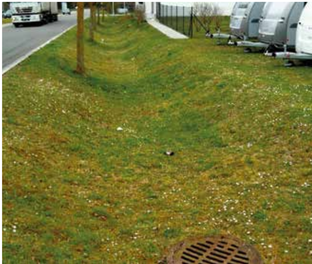
Muldenversickerung im Gewerbegebiet Horheim [Bild: LRA WT]
