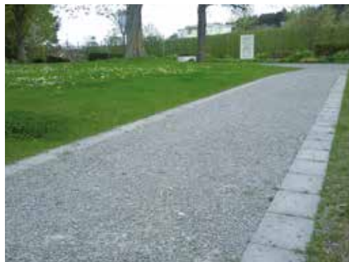
Beispiel einer Splittdecke [Bild: LRA SBK]
