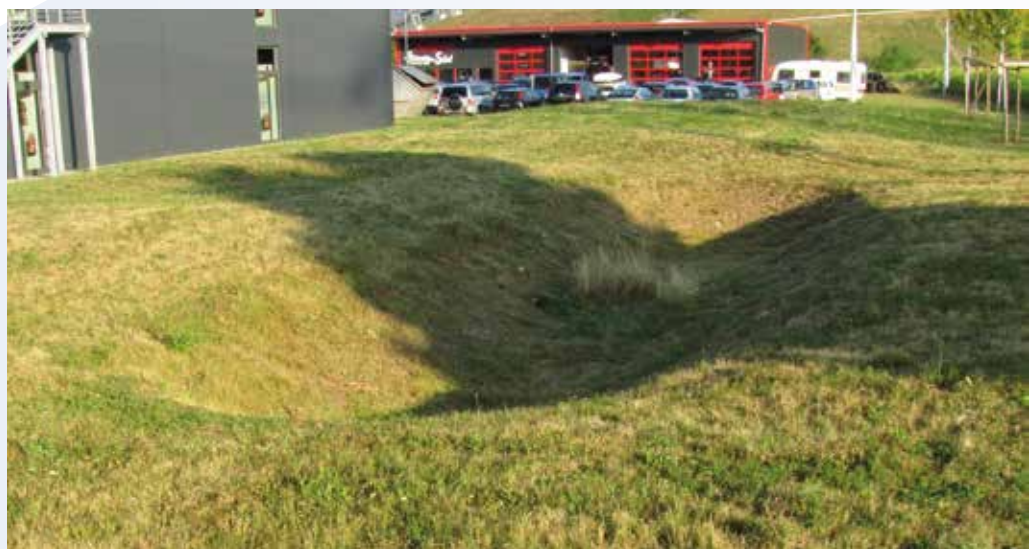
Muldenversickerung im Gewerbepark Hochrhein [Bild: LRA WT]
