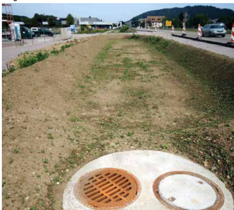
Muldenrigolenversickerung im Bau, Laufenburg, Baugebiet [Bild: LRA WT]
