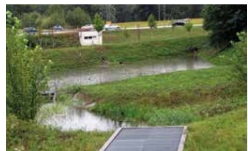
Beckenversickerung im Gewerbepark Hochrhein [Bild: LRA WT]
