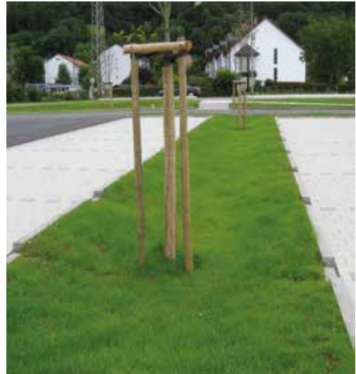
Muldenversickerung von Fahrgassen und Stellplätzen eines Einkaufszentrums [Bild: LRA LÖ]
