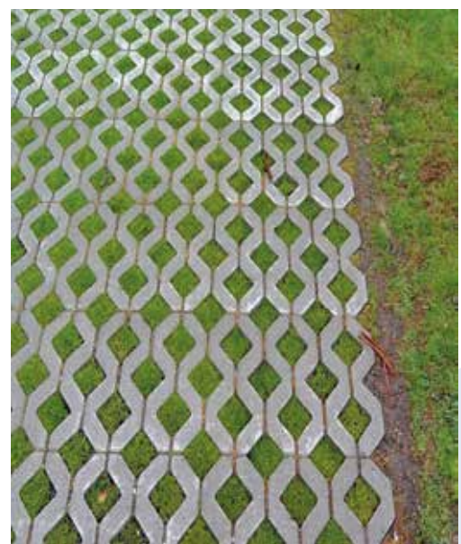
Flächenversickerung [Bild: LRA WT]
