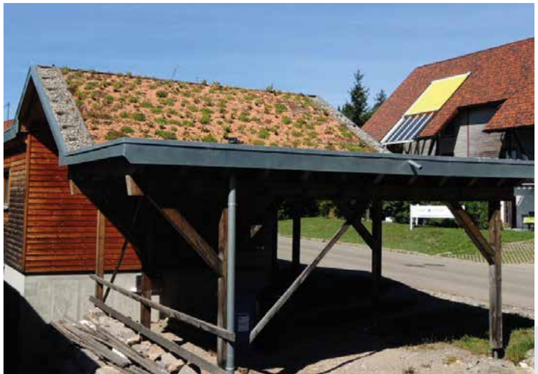
Extensiv begrüntes Dach [Bild: LRA WT]
